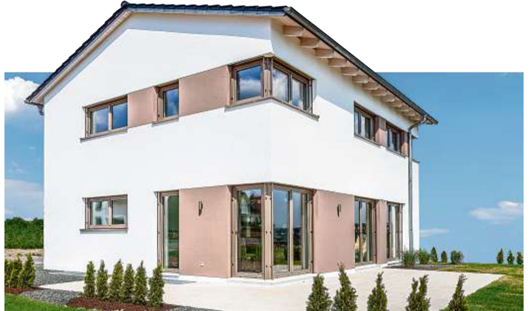
Brohm Massivhaus bietet Qualität in Planung und Ausführung sowie einen hervorragenden Service.
